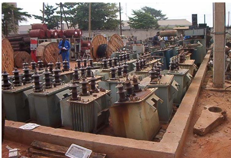
Figure 6 : Magasin non couvert d'équipements divers d'électricité.
