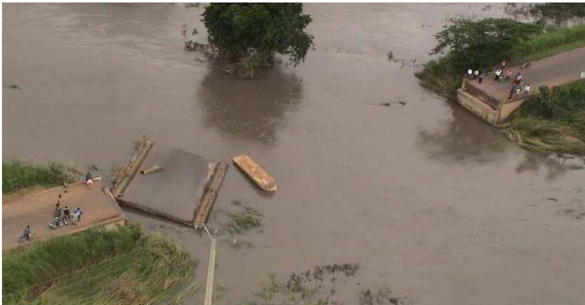
Rupture du pont sur la route nationale N°1 à AMAKPAPÉ
